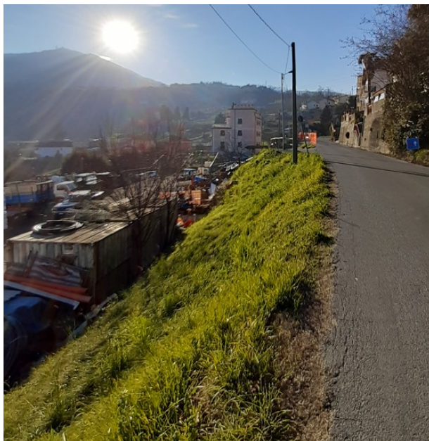
Km5+400 – Inserimento di nuove barriere stradali
