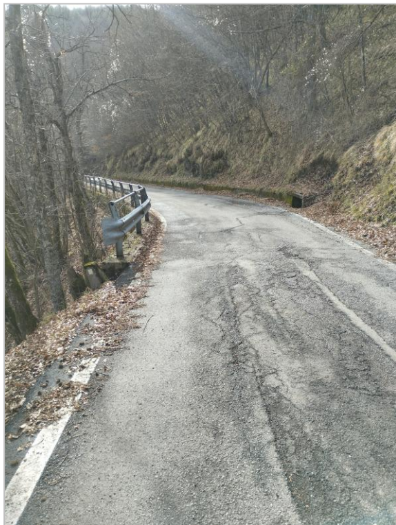
Cordolo su ciglio stradale e cunetta con aletta a monte al km 2+550
