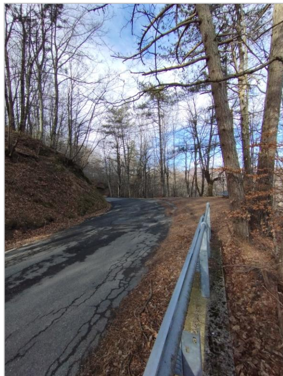
Cordolo su ciglio stradale al km 3+950
