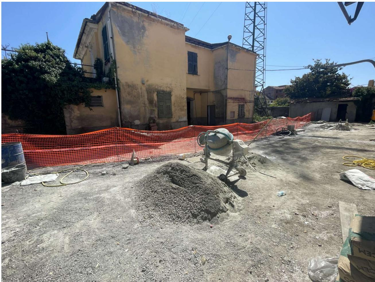
Il piazzale in quanto area condivisa ai due cantieri dovrà essere diviso da recinzione con altezza tale da impedire l'ingresso ai non addetti ai lavori. La recinzione potrà essere realizzata con rete plastificata arancione ad alta visibilità debitamente legata a tondini in ferro infissi nel terreno con lato libero protetto da tappi a fungo in plastica. Sulla recinzione dovrà essere apposto cartello indicante il divieto di accesso.
