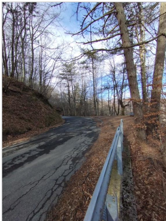
Cordolo su ciglio stradale al km 3+950
