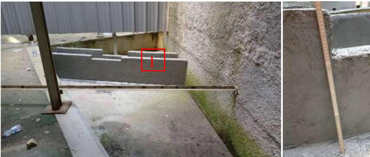
**Figura 13** muri di sbarramento e dettaglio della soglia di troppo pieno dello sbarramento “2”
