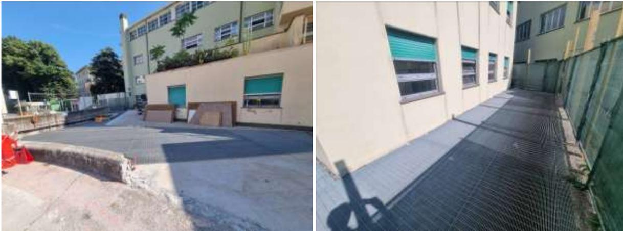
**Figura 9** vista delle griglie di aerazione autorimessa interrata e raccolta acque sul lato nord est e nord ovest dell'edificio.
