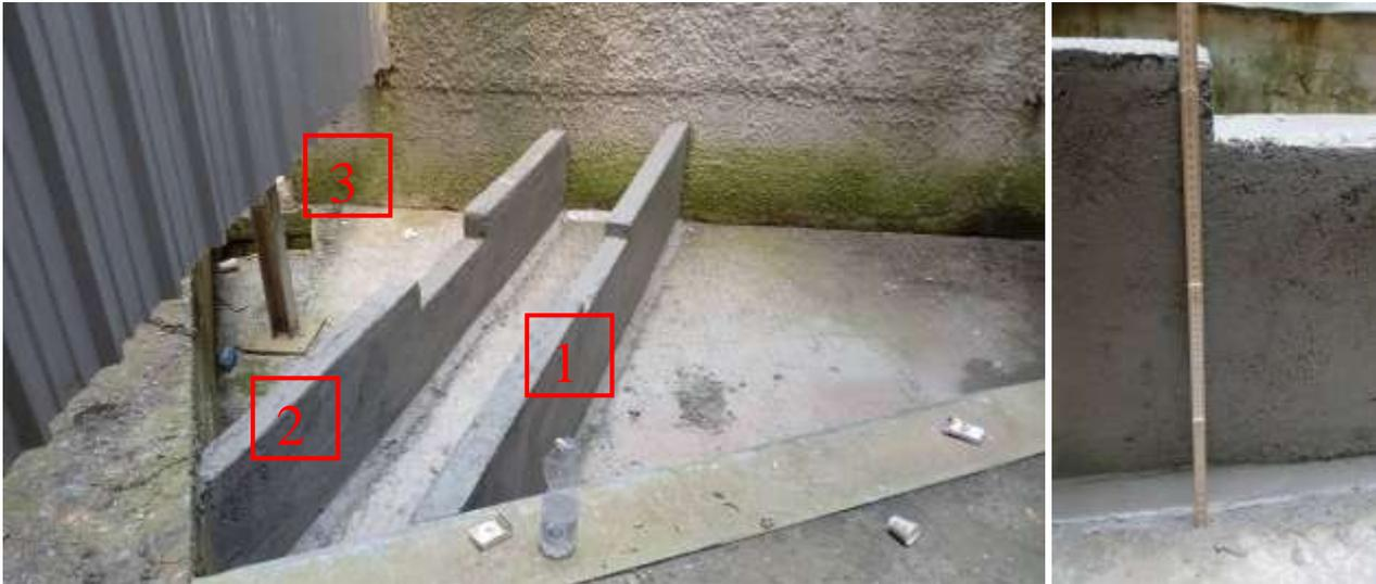
**Figura 12** muri di sbarramento e dettaglio della soglia di troppo pieno dello sbarramento “1”
