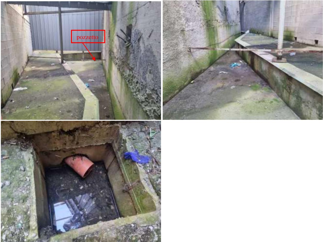
**Figura 10 a,b,c** intercapedine e pozzetto di raccolta acque e immissione nella rete di smaltimenti acque meteoriche preesistente
