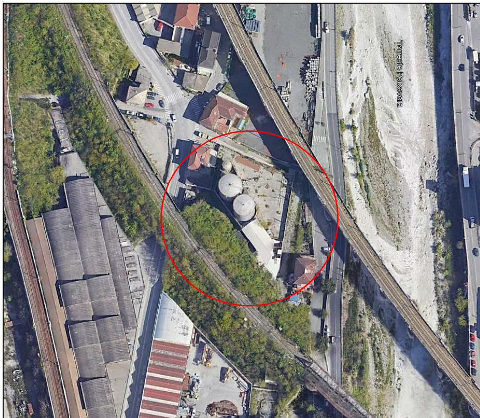
Figura 1: Foto aerea dell'ex deposito (fonte Google Earth)
